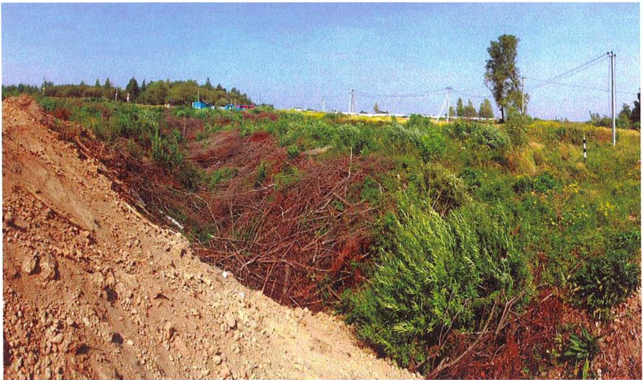
Wycięte drzewa i krzewy w osi podejścia w odległości ok. 700 m od progu DS 26.
